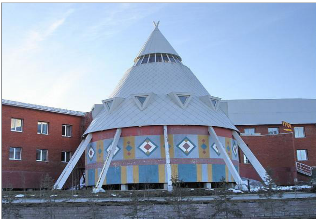
Дом народов Севера в г. Якутске
